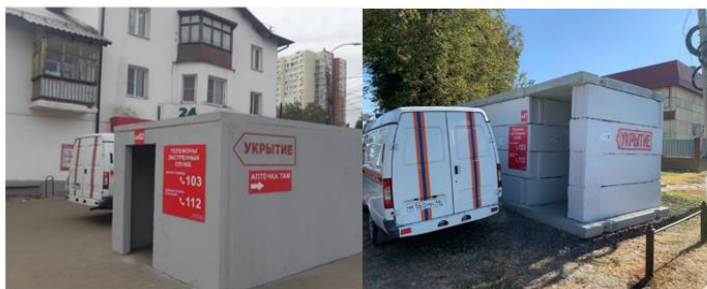
Установлено 71 железобетонное модульное сооружение
